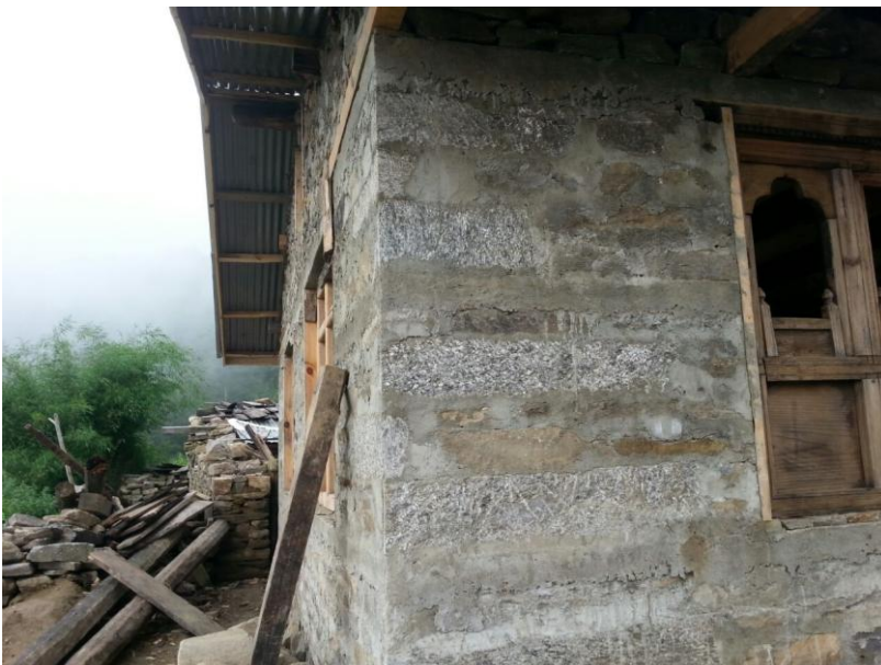
Wie schön, ein alter Fensterrahmen wurde wieder verwendet
